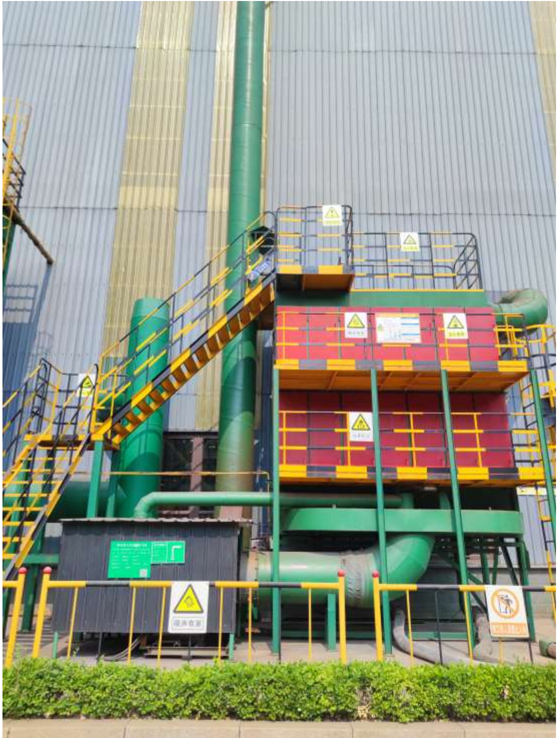
抛丸废气排气筒P1-1
