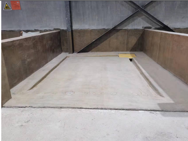
库位防腐防渗
