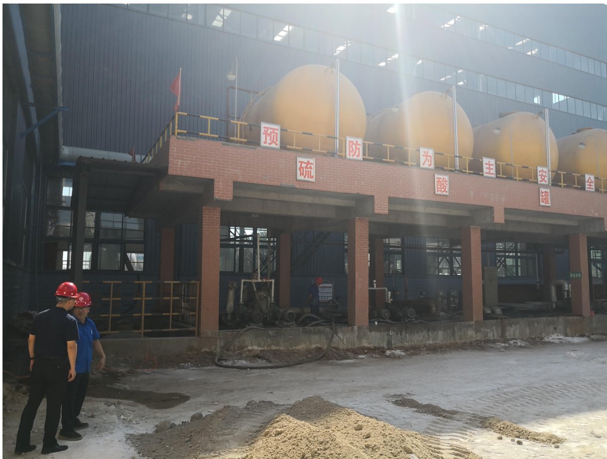
目前正在进行整改的硫酸罐区及装卸区
